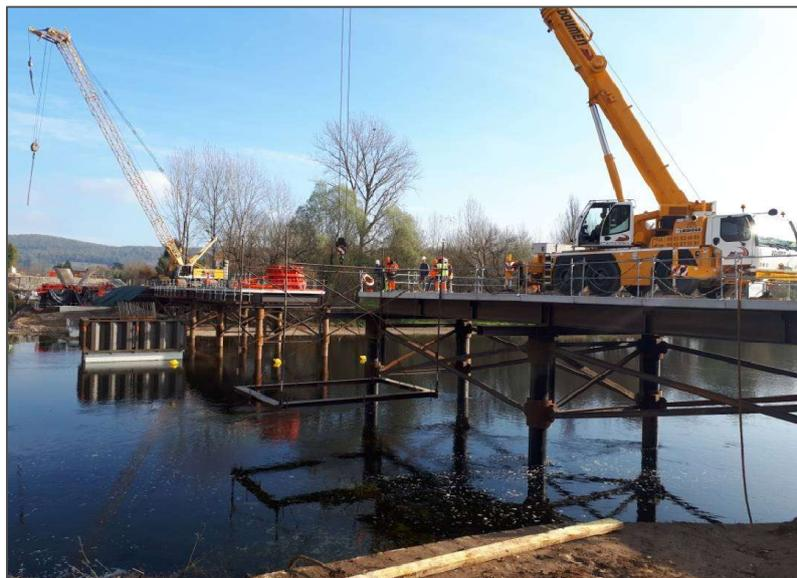
Une estacade métallique sera mise en place pour permettre aux engins de chantier d'accéder aux zones à construire
