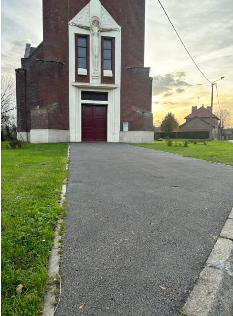
Aménagement des abords de l'église
