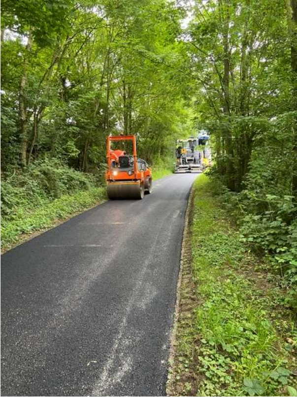
Réfection du chemin rural d'accès à la vallée œufs (financement par la SGAMI en totalité)
